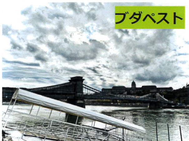
くさり橋工事中、夜間のライトアップも 中止されています
